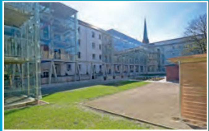
Neulandstraße Innenhofansicht nachher
