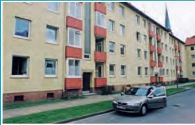
Neulandstraße Innenhofansicht vorher
